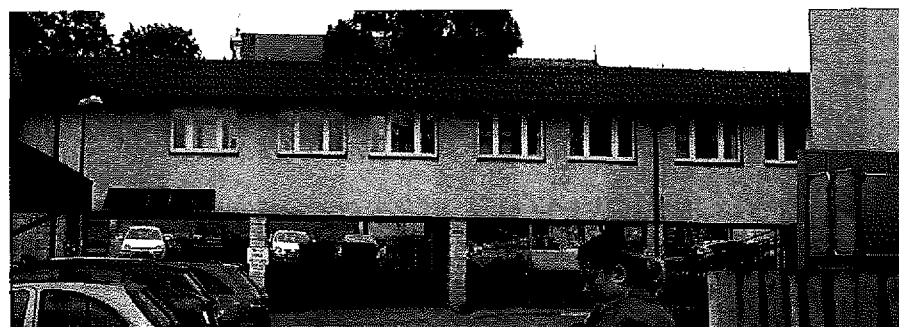
Elewacja budynku E
