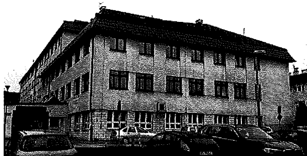
Elewacja budynku B
