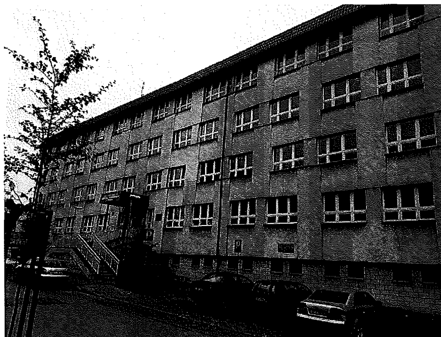
Elewacja budynku A
